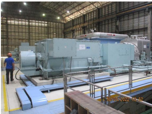
รูปที่ 41 เครื่องกำเนิดไฟฟ้าสำรอง
