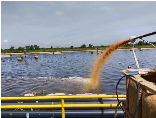
รูปที่ 23 การเติมสารปรับสภาพระบบบำบัด
