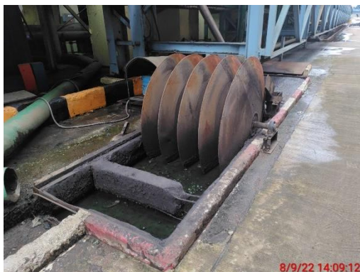
รูปที่ 27 บ่อแยกน้ำมัน
