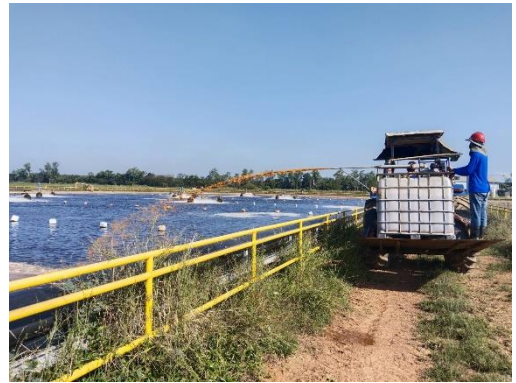
รูปที่ 23 การเติมสารปรับสภาพระบบบำบัด
